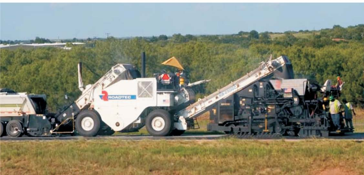
На укладчик SP-200 устанавливается гидравлически расширяемая вибрационная плита Eagle 10. Распылительная штанга расширяется вместе с расширениями плиты. Избыток вяжущего собирается в поддон и затем стекает обратно в подогреваемый резервуар для вяжущего.
